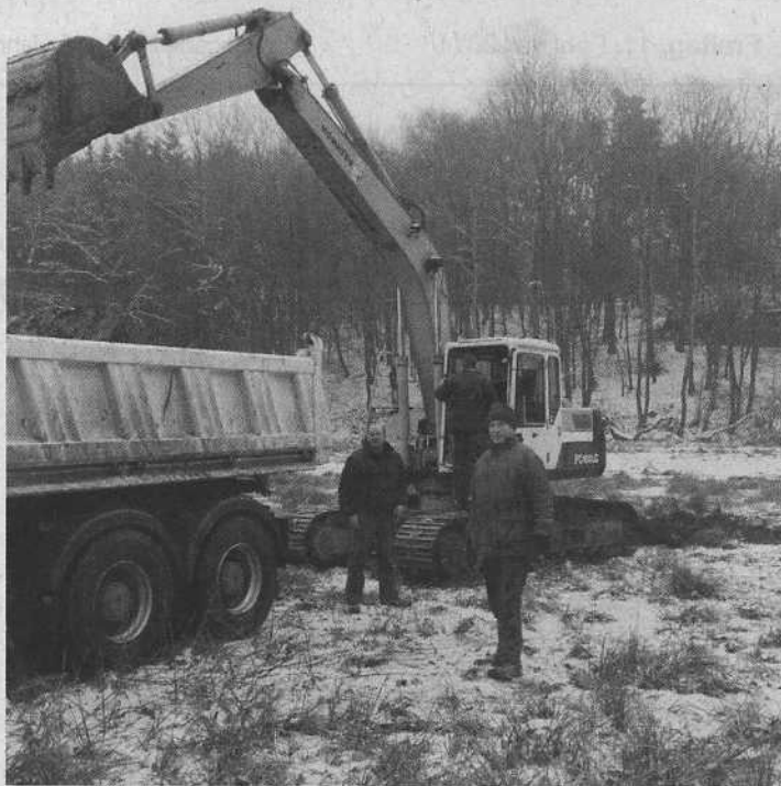
Mit Bagger und Transportfahrzeugen wird die lehmige Erde ausgehoben.
